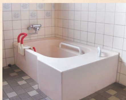
●個人浴槽 4か所(うちリフト付1か所)
